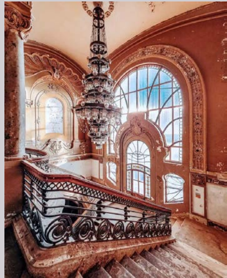
Înainte de renovare / Before reconstruction
